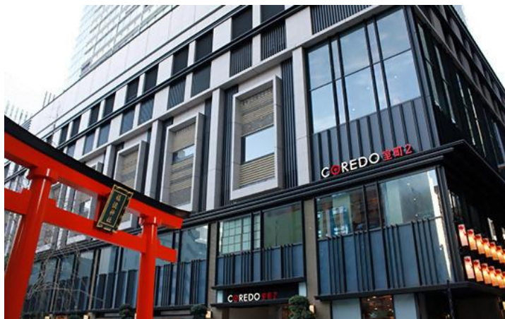
日本橋室町コレド室町2(室町古河三井ビルディング)
