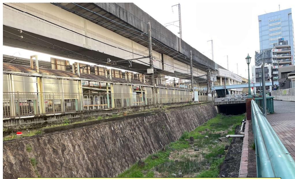
石神井川支流の都電脇の現状
