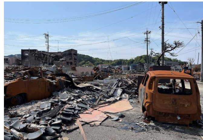
能登半島地震の市街地火災(輪島市)
