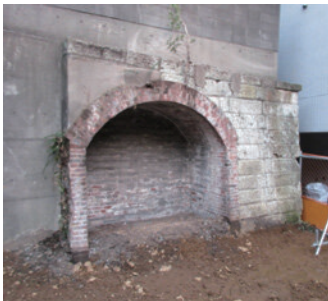
滝野川小学校で見つかった防空壕跡
