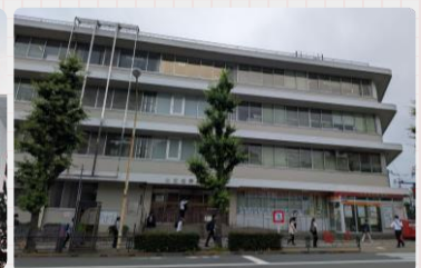
↑ 現庁舎(第二庁舎)
