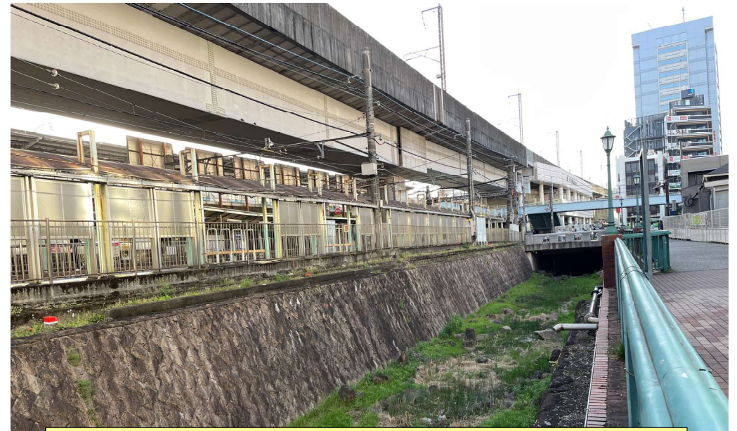
石神井川支流の都電脇の現状
