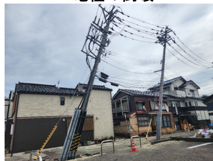
電柱の倒壊
