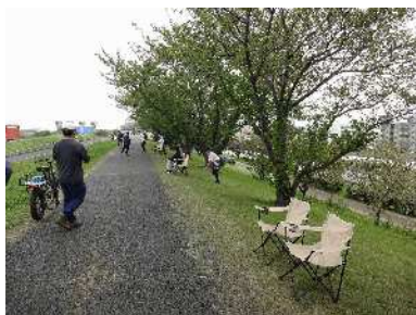
【写真①】 堤防天端拡幅部の検証
