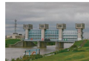
現在の岩淵水門 (出典：荒川放水路変遷誌)
