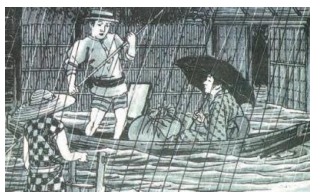
明治時代の洪水被害 (出典：写真集荒川下流75年の流れ)
