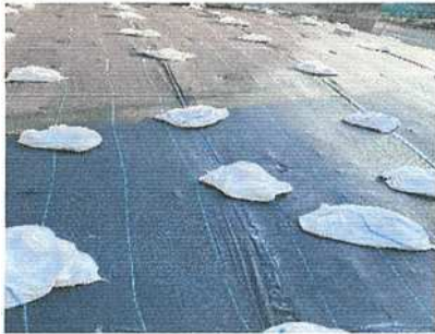
↑近所の工事現場の様子
