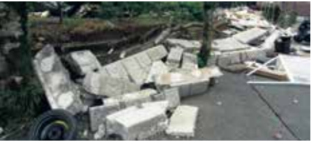
平成28年熊本地震によるブロック塀の倒壊 出典：(一財)消防防災科学センター災害写真データベース
