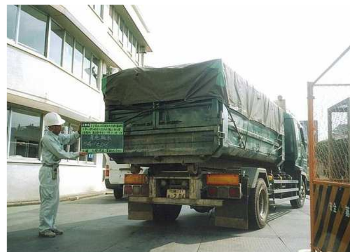
⑦除去材の処分
