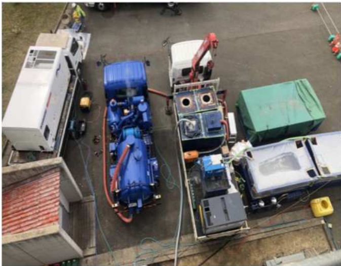
① プラント設置
