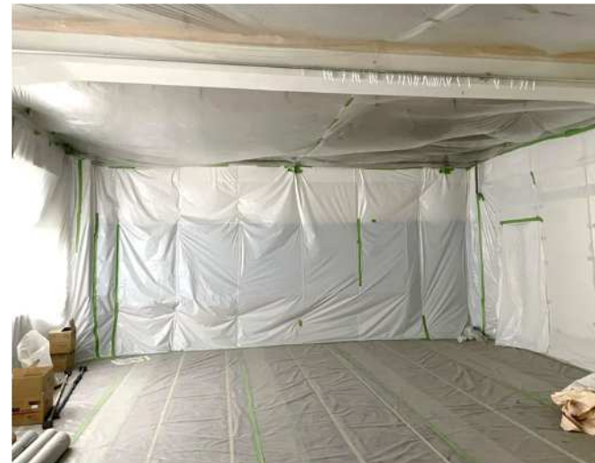
② 飛散防止養生 (内部)
