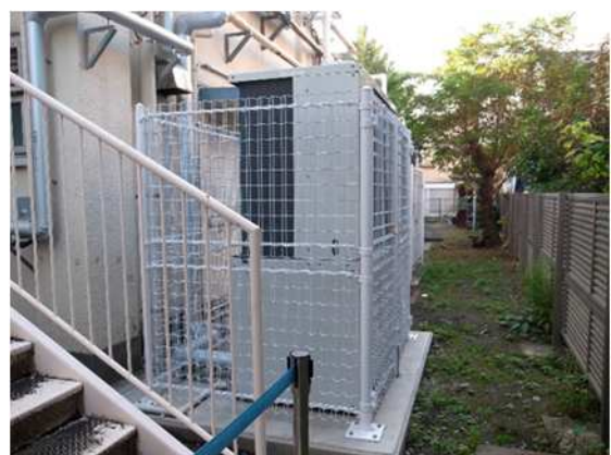
⑧校舎裏（北側敷地境界）
