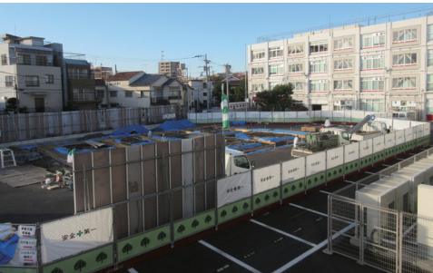
分庁舎に建設中の保育園
