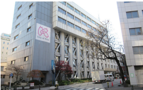
耐震改修後の本庁舎
