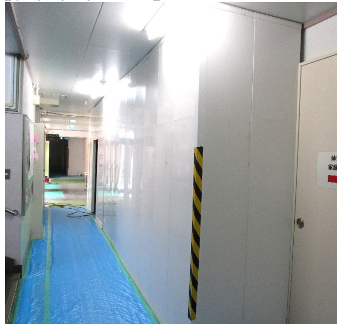
【仮設間仕切り】
