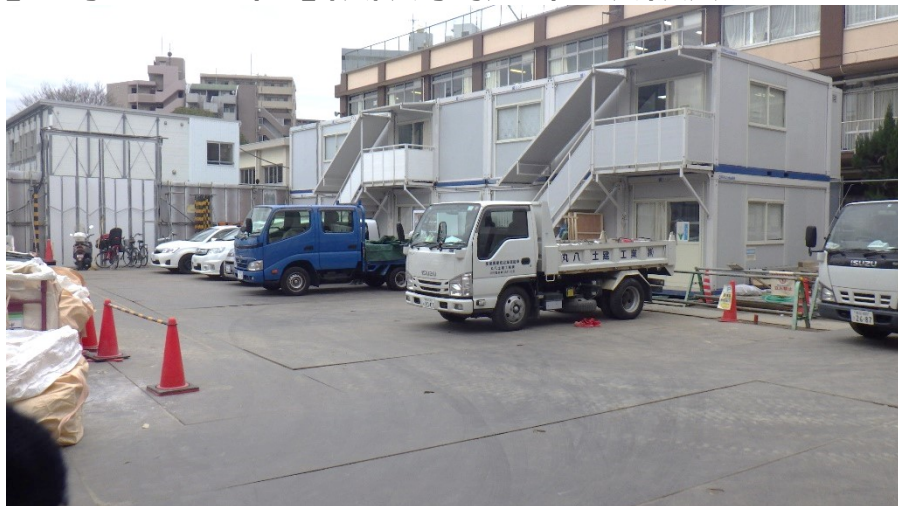
【工事ヤード内】仮設事務所、鉄板敷き
