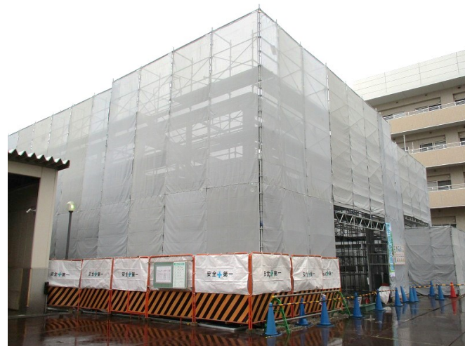
【外部足場】足場、メッシュシート
