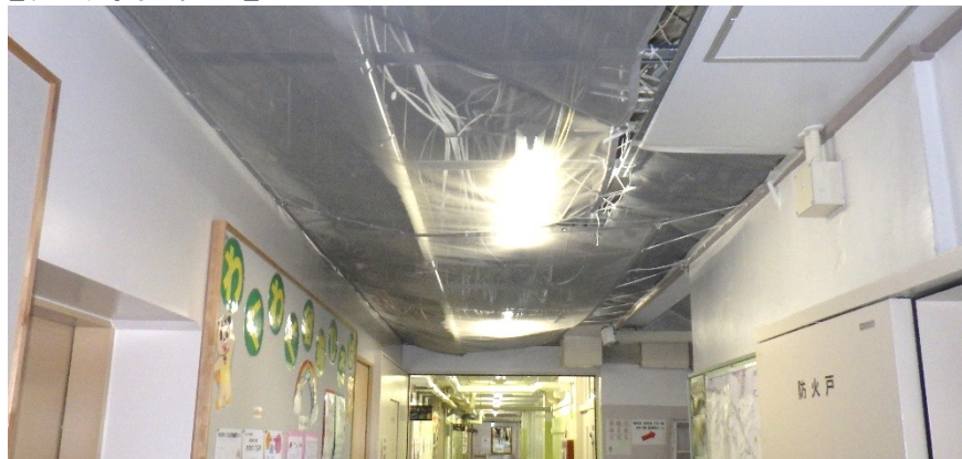
【天井養生】メッシュシート
