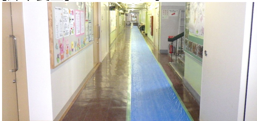
【廊下養生】ブルーシート等
