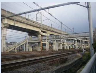
稲荷前跨線人道橋
