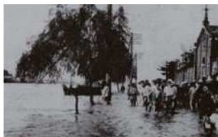
明治43(1910)年 洪水被害 (出典：荒川放水路変遷誌)
