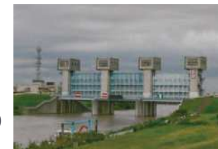
現在の岩淵水門 (出典：荒川放水路変遷誌)
