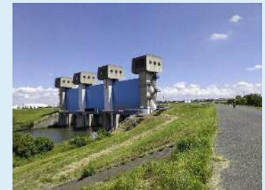
隅田川の最上流に立つ岩淵水門（青水門）
