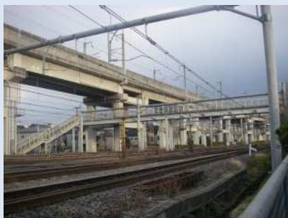
稲荷前跨線人道橋
