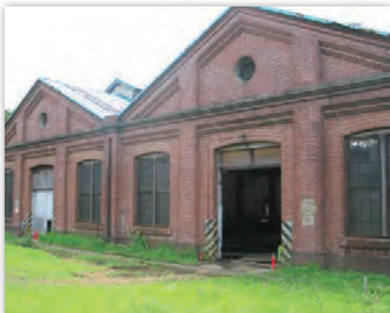
中央図書館への工事前の様子
