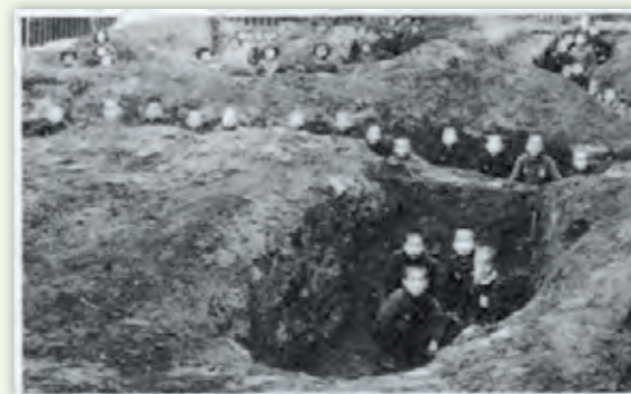
滝野川第三国民学校の校庭に掘られた防空壕 昭和10年代(滝野川第三小学校創立六十周年記念誌) 多くの児童が避難するため、各学校には長い防空壕がつくられた。
