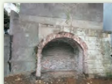
北区に残る防空壕 昭和10年代(令和7年撮影) 上)赤羽台さくら並木公園にて。入り口からは、だんだんと下っていく穴の様子が見える。 下)滝野川小学校前に残る防空壕。(中には入れません)
