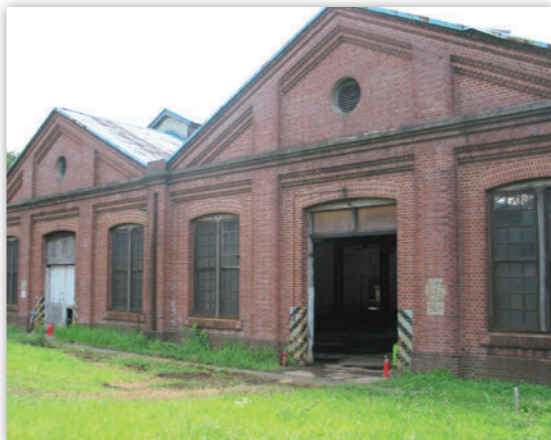
中央図書館への工事前の様子
