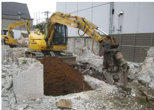
基礎等取壊し工（油圧圧砕機等）
