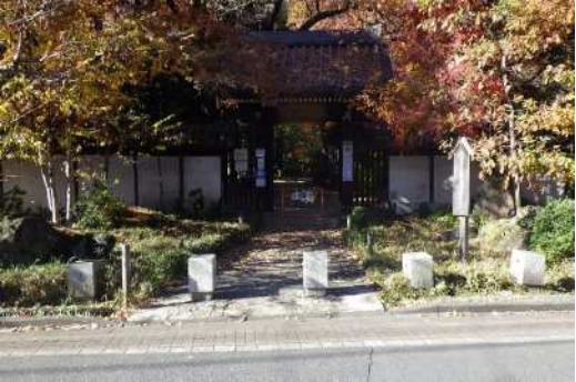
現況写真（薬医門前）
