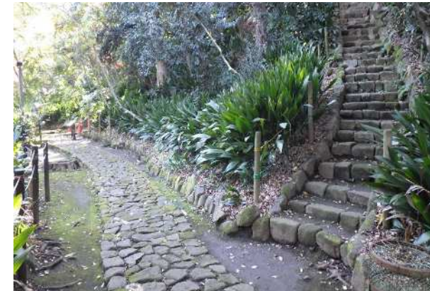
現況写真（斜面散策路）
