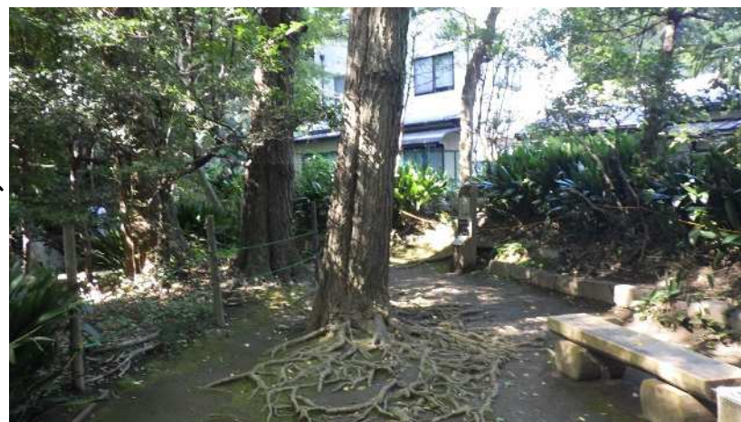
現況写真（舗装通路）
