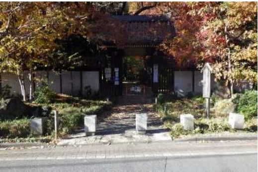
現況写真（薬医門前）
