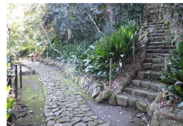
現況写真（斜面散策路）
