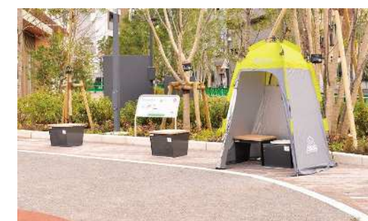
マンホールトイレ
