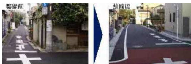
▲主要生活道路の整備例（道路拡幅・無電柱化） ※出典：災害に強い首都「東京」の形成に向けた連絡会議資料（東京都）
