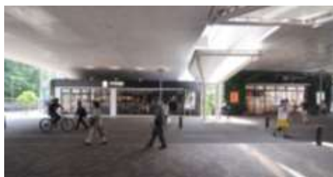
武蔵境駅西側高架下（武蔵野市）
