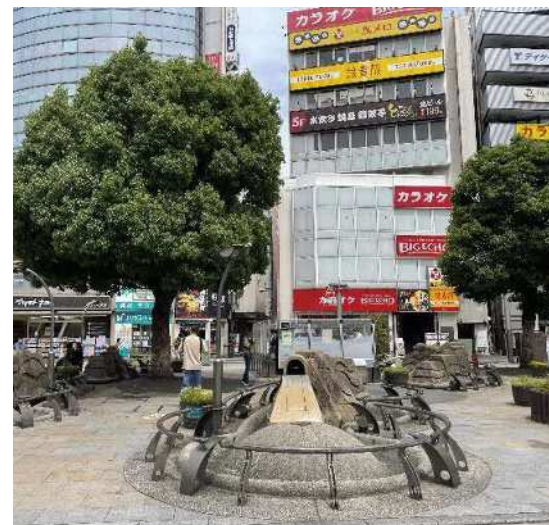
□ 稼働していない噴水
