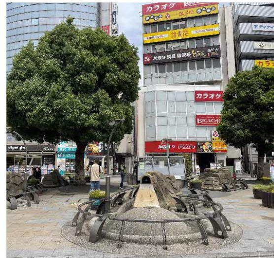
□稼働していない噴水
