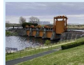
旧岩淵水門（赤水門）
