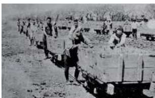
人力掘削の様子 (出典：荒川放水路変遷誌)
