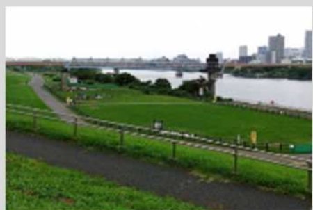
荒川緑地と防災船着場
