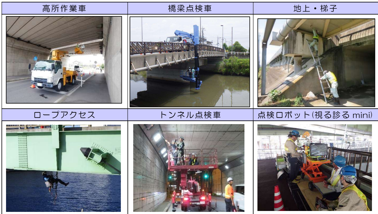
図 2-1 点検実施方法（実績）
