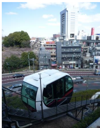
アスカパークレールのアスカルゴ
