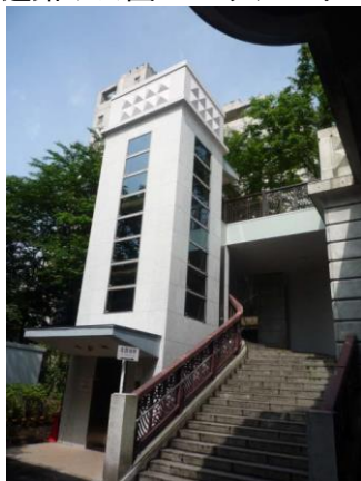
音無橋脇昇降施設（エレベーター）
