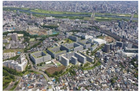
都市再生機構ヌーヴェル赤羽台 (写真：2025年6月)
