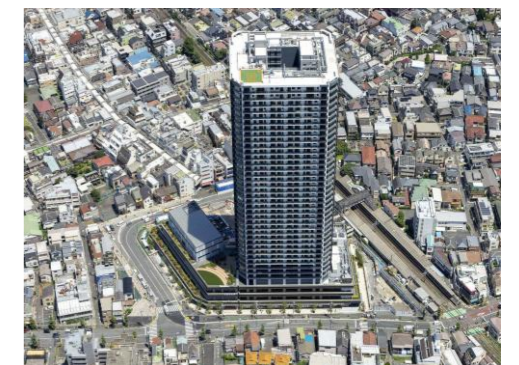
十条駅西口地区市街地再開発事業 再開発ビル航空写真
