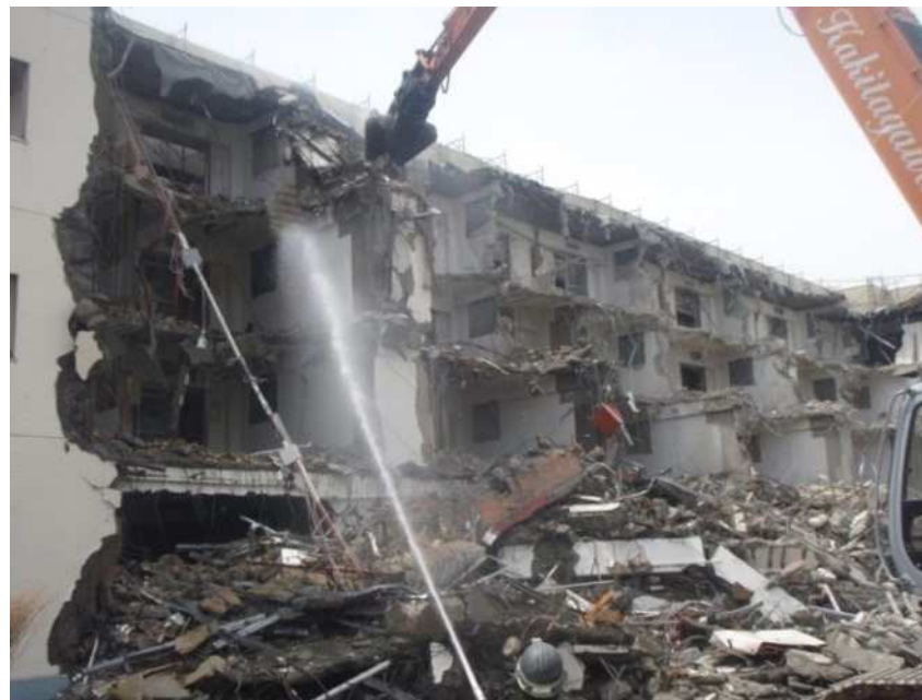
散水しながらの解体作業
