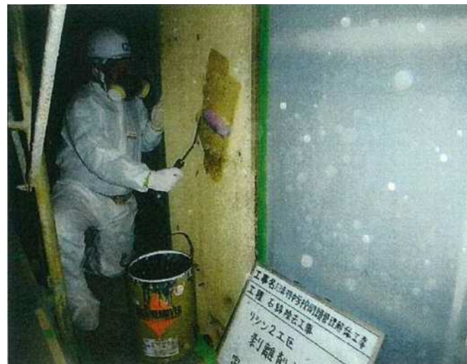
② 剥離剤塗布
