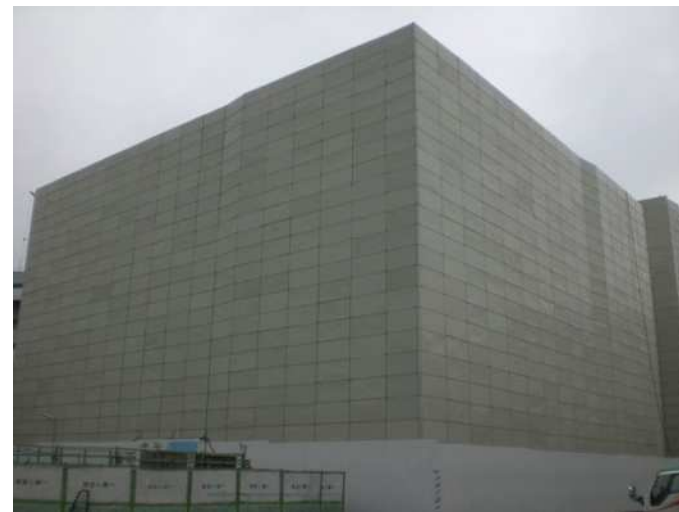
防音パネル張り
